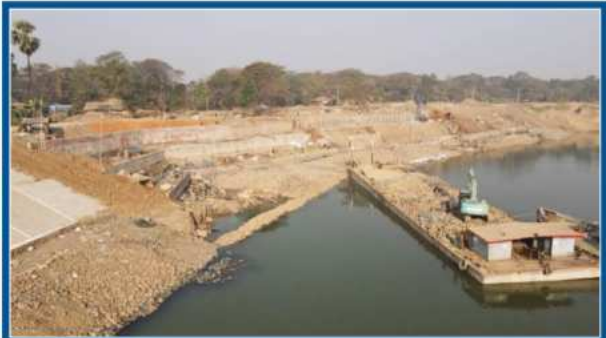
ထူပါရုံဘုရားအထက်ဘက် ကမ်းပြိုကာကွယ်ရေးလုပ်ငန်းဆောင်ရွက်နေပုံ
